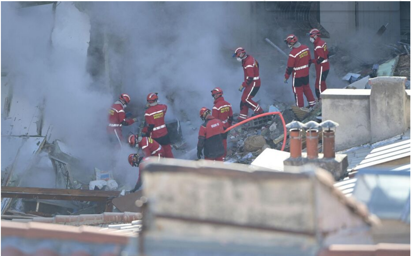
Un immeuble s'est effondré rue Tivoli, à Marseille, en avril 2022. CLEMENT MAHOUEAU / AFP
