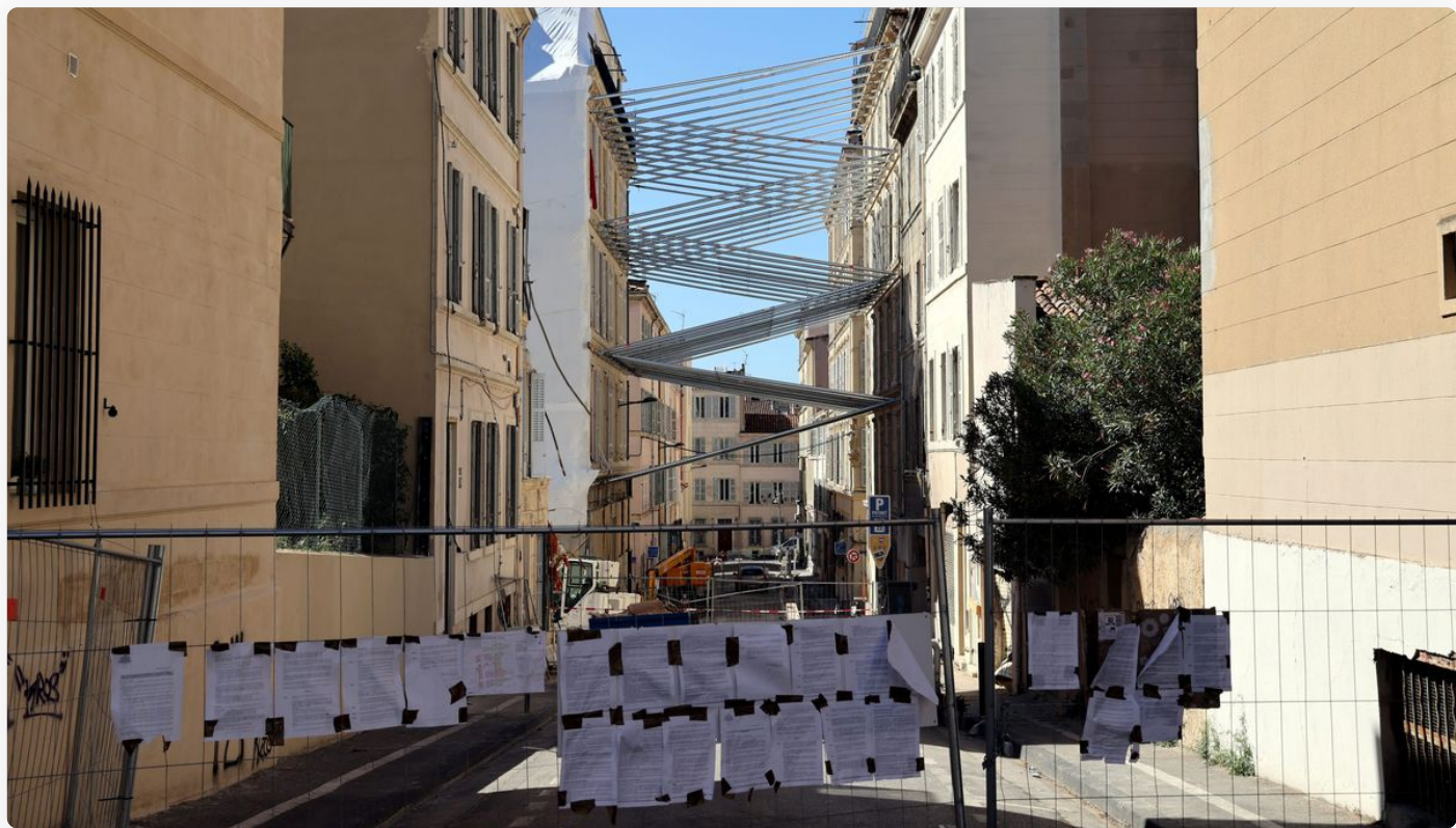
La rue de Tivoli encore bouclée, un mois après l'effondrement de deux immeubles dans la nuit du 8 au 9 avril 2023 © Maxppp - VALLAURI Nicolas
